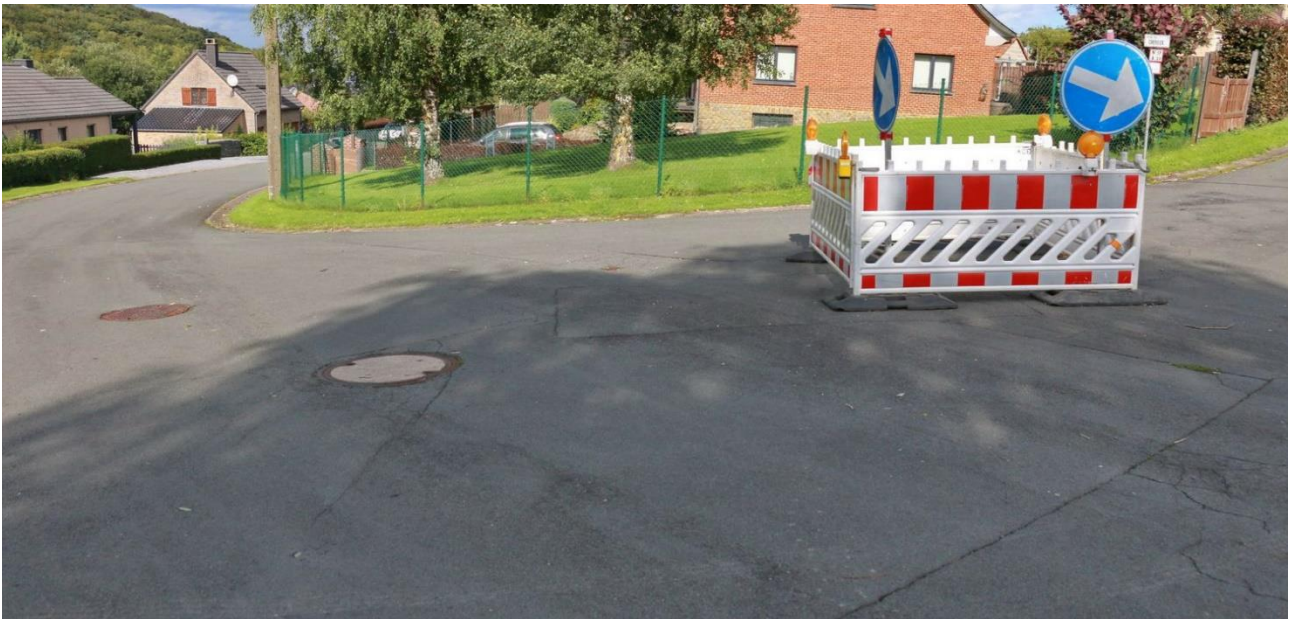
Fig. 9. Effondrement du carrefour. La présence de plusieurs canalisations (matérialisées par les taques d'égouts) et de fissures linéaires sur une importante distance semblent indiquer que la zone déstabilisée est bien plus étendue que le trou actuel.
