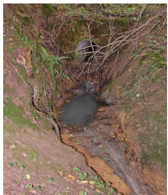
Fig. 11. Rejets d'eau usées dans le vallon de Beauregard, en provenance des maisons d'Avister.
